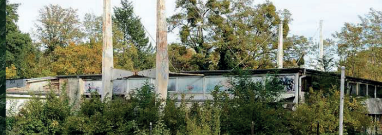
Kern des Sanierungsprojekts LOTTENHOF: „Gaststätte Charlottenhof“, 1971 erbaut
